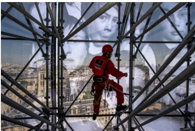
Installation des panneaux de la bâche extérieure du dôme - 16 mai
